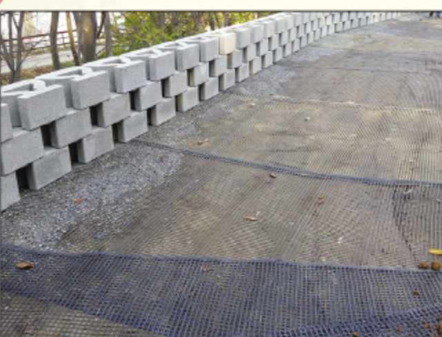
연속작업 - 그리드 포설 및 다음단 쌓기 (60cm 마다 웅벽높이의 70%이상의 그리드 포설)
