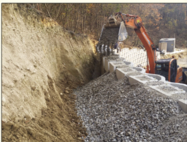
연속작업 - 속, 뒷채움 잡석 및 흙 부설
