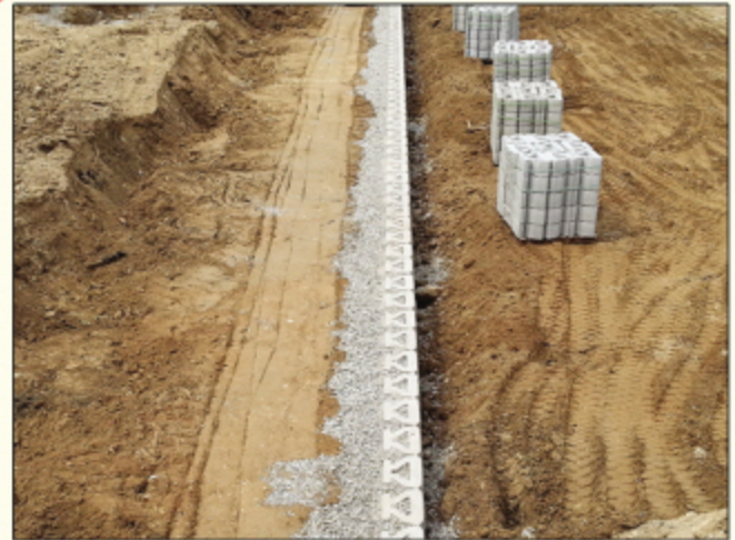
첫단쌓기 및 유공관 설치
