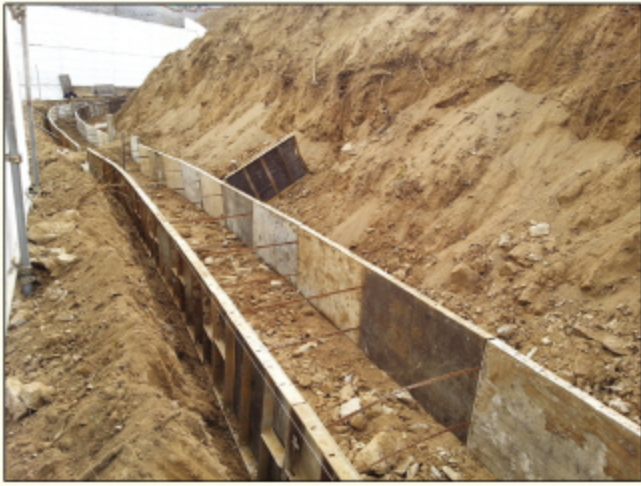
터파기 및 기초작업 (기초 콘크리트 타설 / 기초잡석 40mm 이하)
