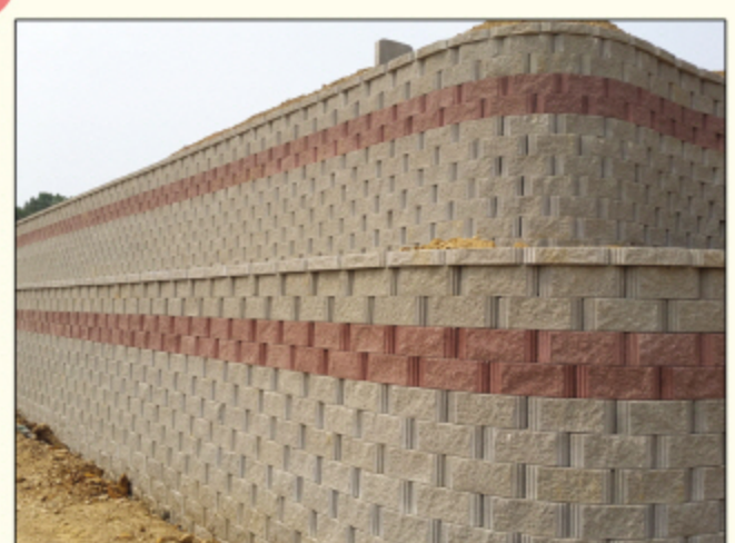
마감블록 설치 및 완공
